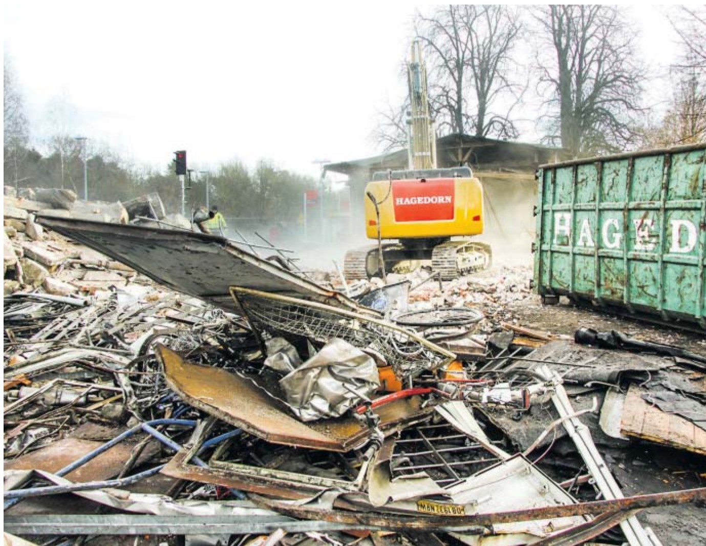
Schlusspunkt: Einen Großteil des maroden Bahnhofsgebäudes hat der Abriszbagger bereits in ein Durcheinander von Steinen, Holz und Schrott verwandelt. Die Materialien werden getrennt sortiert. Hinter dem Staub sind die Bahnsteiganlagen zu sehen FOTO: SUSANNE LAHR
